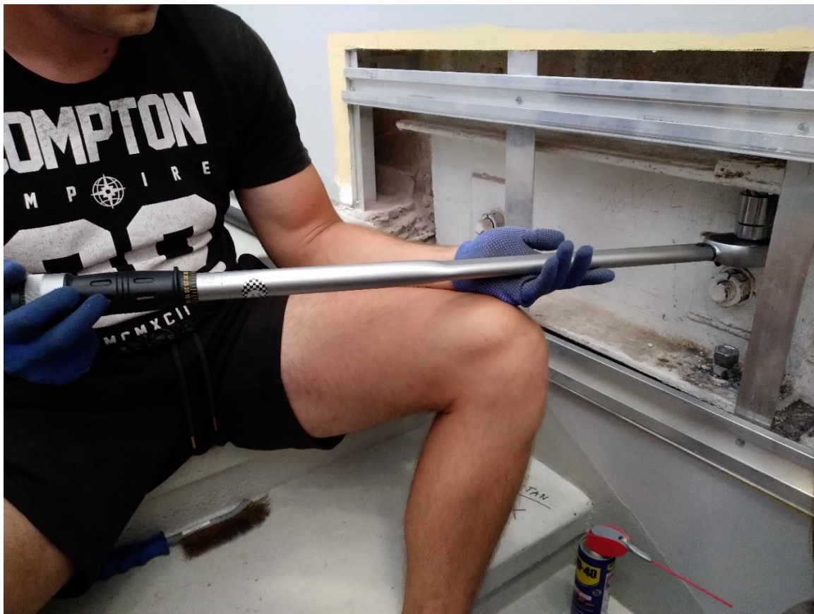
Fot. 3 – Sprężanie połączeń elementów konstrukcji.
