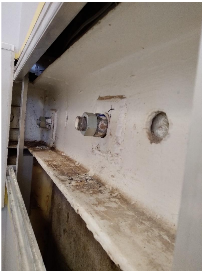
Fot. 10. Zamontowane nakrętki kontrujące M30 wieńca wewnętrznego.
