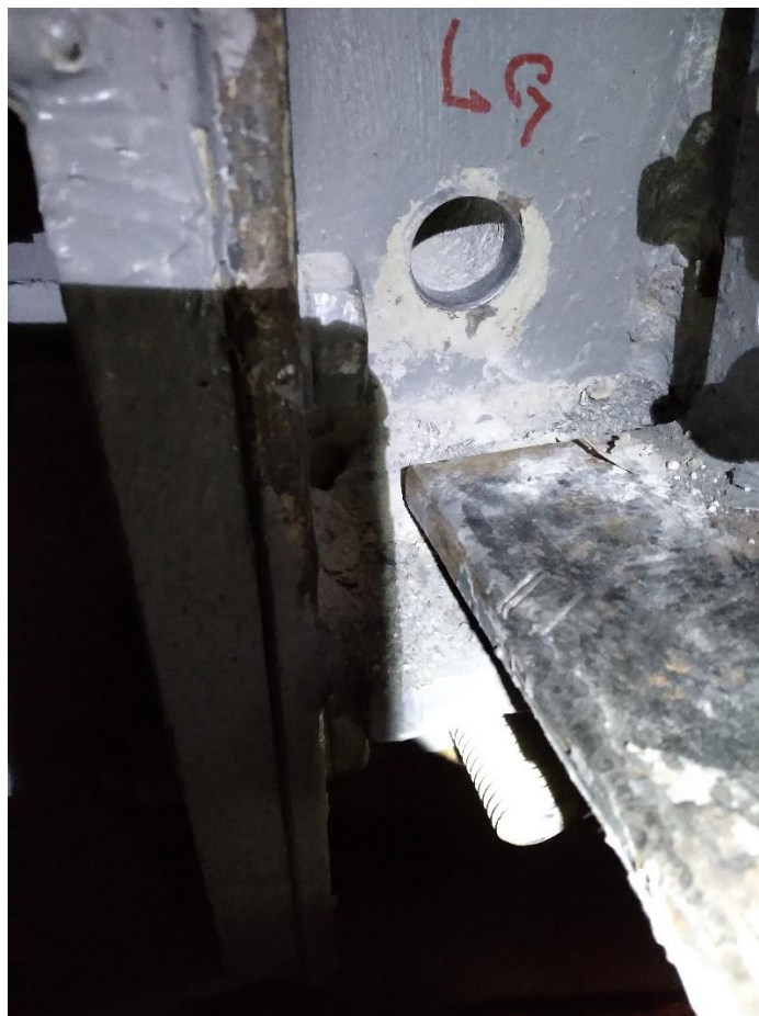
Fot. 17. Przygotowany otwór do montażu nowej kotwy w wieńcu W-2-2 (opis w sprawozdaniu technicznym).
