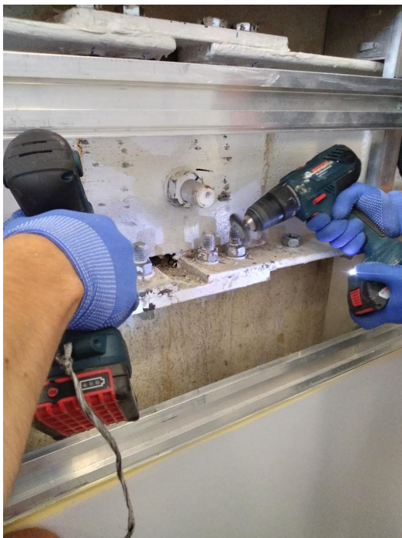
Fot. 6 – Mechaniczne oczyszczanie gwintów z farby przed montażem nakrętek kontrujących.
