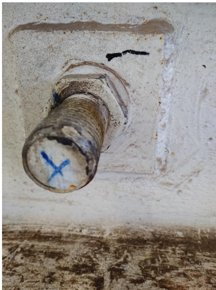
Fot. 12. Brak nakrętki kontrującej M30 (uszkodzony gwint).
