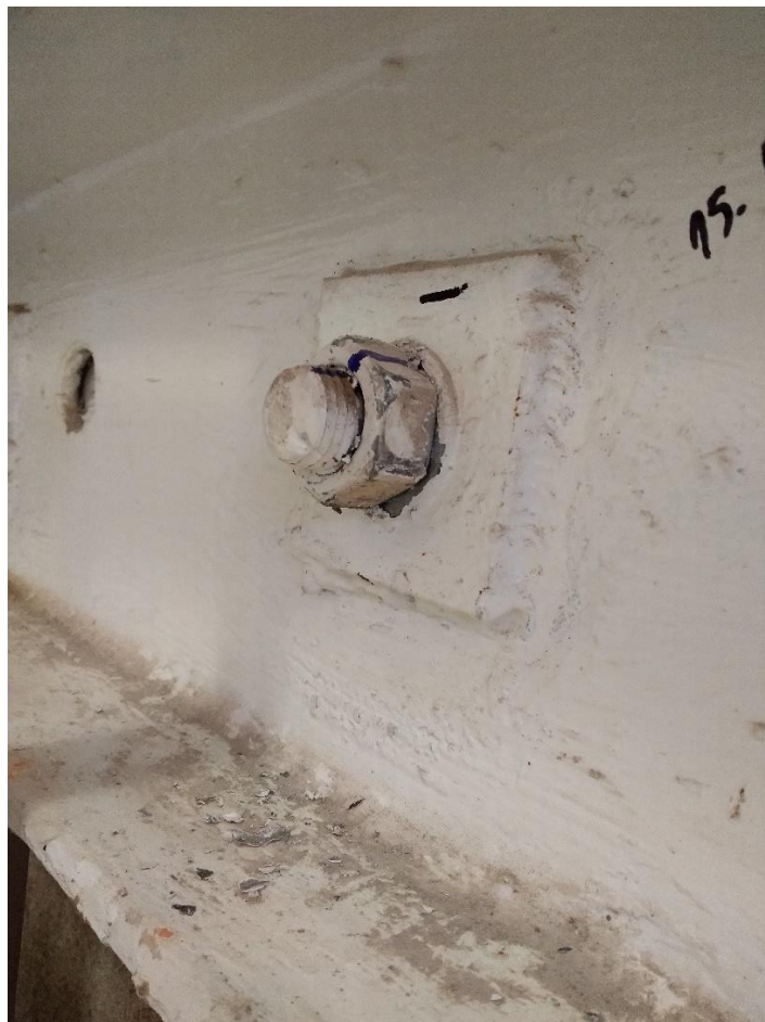
Fot. 13. Brak nakrętki kontrującej M30 (za krótki gwint).
