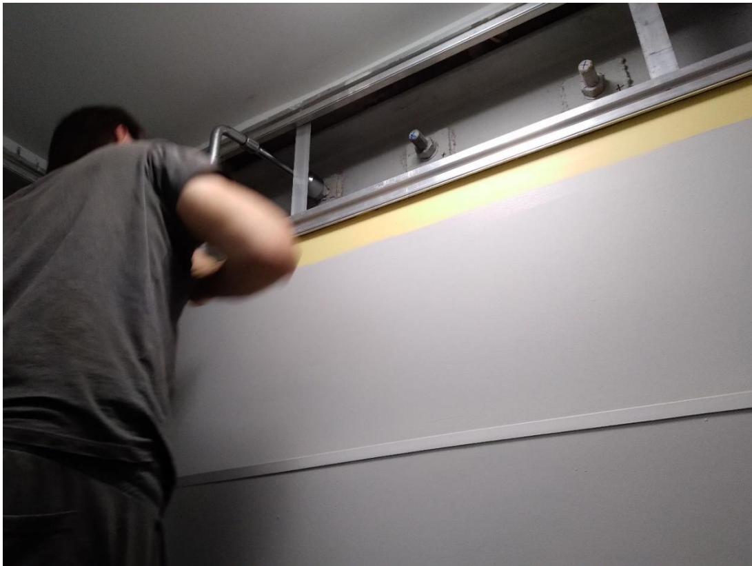
Fot. 5 – Kontrola dokręcenia śrub M30 siłą na kluczu 1 KG.
