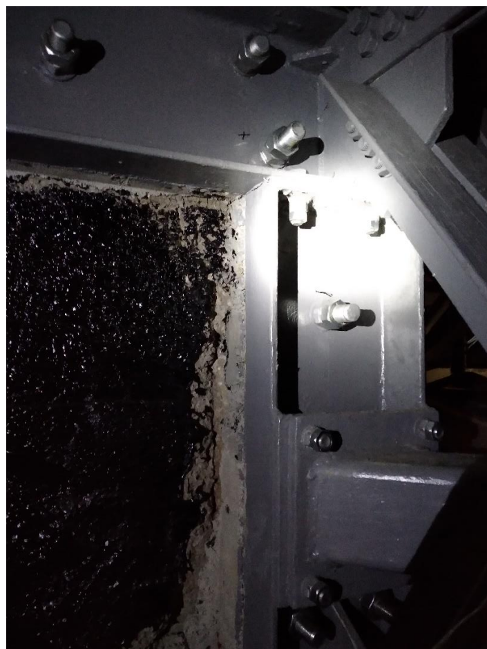
Fot. 14. Zamontowane nakrętki kontrujące M20 i M30 wieńca zewnętrznego.
