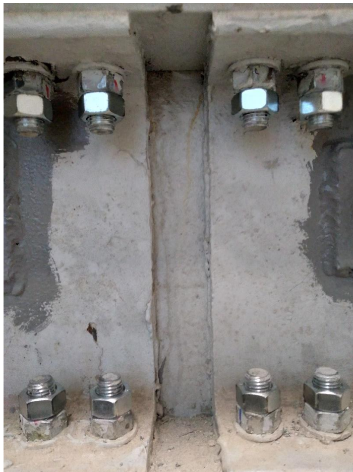
Fot. 9. Zamontowane nakrętki kontrujące M20 wieńca wewnętrznego.
