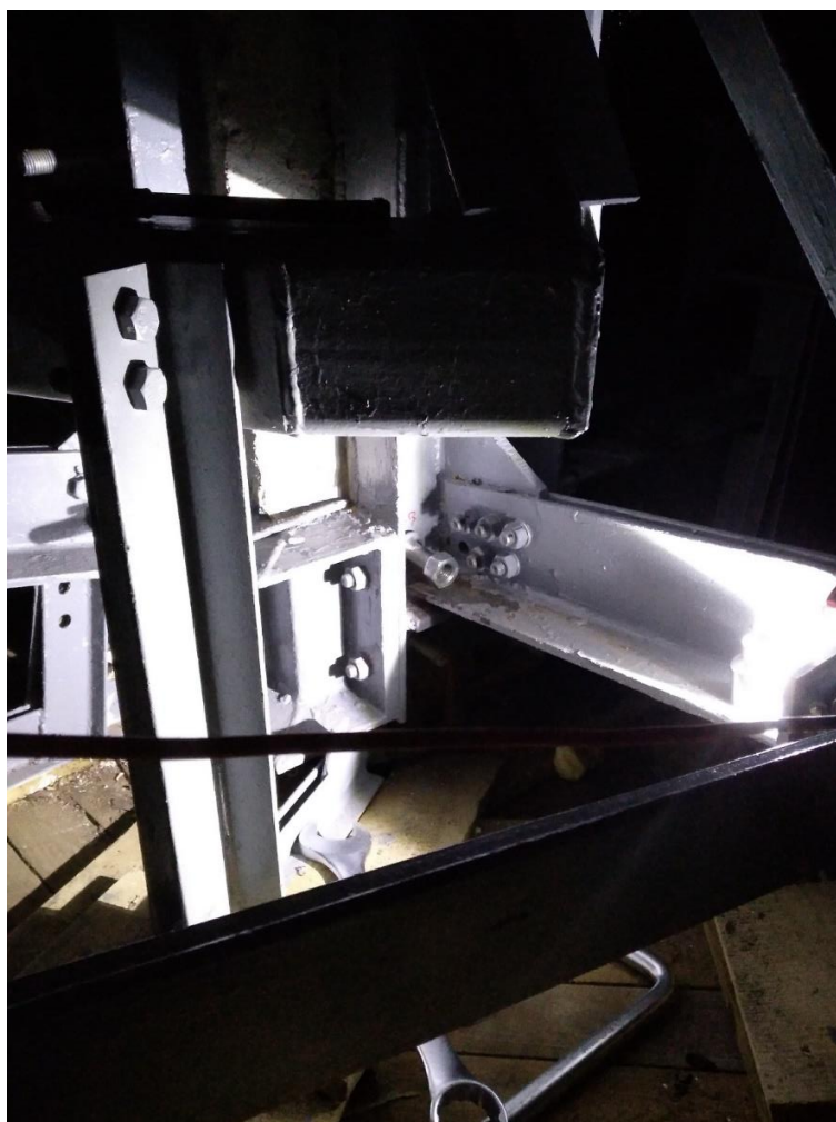
Fot. 16. Pozostawiona luźna kotwa wieńca W-2-2 (opis w sprawozdaniu technicznym).
