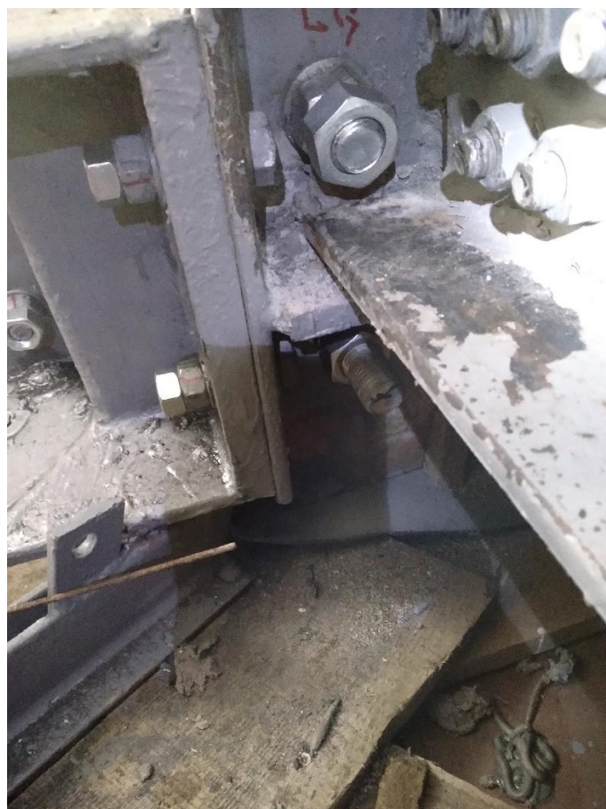
Fot. 18. Zamontowana nowa kotwa z pręta gwintowanego M30 o długości 300 mm w wieńcu W=2-2 narożnika południowo-zachodniego wraz z nakrętką kontrującą (opis w sprawozdaniu technicznym).
