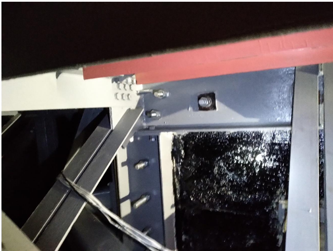
Fot. 15. Zamontowane nakrętki kontrujące M20 i M30 wieńca zewnętrznego.
