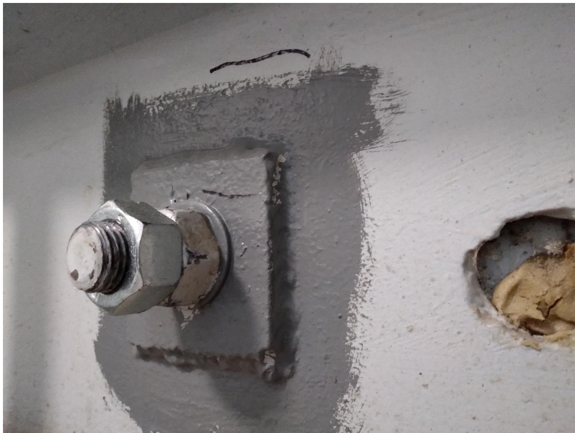
Fot. 11. Zamontowana nakrętka kontrująca M30 wieńca wewnętrznego.
